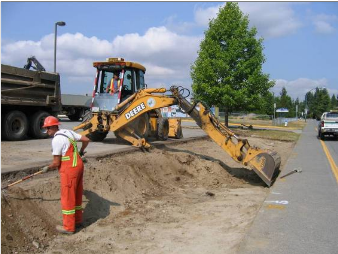
Swale excavation (August 2006)
